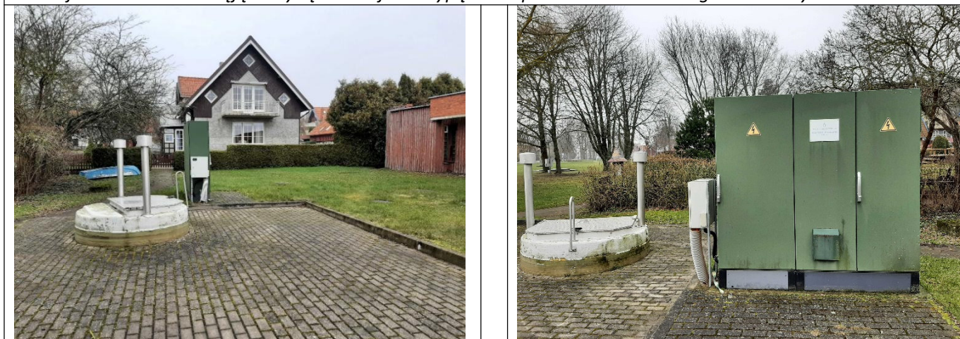
Inžineriniai statiniai planuojamame sklype G. D. Kuverta g. 1C, Neringa. Požeminė nuotekų siurblinė ir valdymo skydas.
